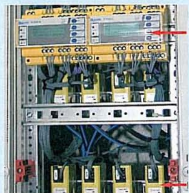
10 Differenzstrom-Überwachungssystem in einer Anlage bestehend aus RCMS460 und Messstromwandler D Differenzstrom-Überwachungsgerät Typ RCMS 460 M Messstromwandler
