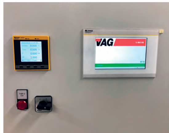
Der Condition Monitor CP907-I gibt Auskunft über den Systemzustand
